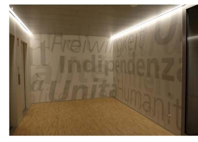
Tageslichts bis in die Mittelzone. Während der Dämmerung werden die Kerne der Mittelzone durch in der Decke eingelassene Linienbeleuchtungen akzentuiert, welche den Raum entlang den Kernwänden mit Streiflicht ausleuchten. Die individuelle Arbeitsplatzbeleuchtung wurde in den Büros mittels Stehleuchten sichergestellt. Vor dem Gartengeschoss wurden blaue Glasmurmeln aufgeschüttet, diese sorgen dank Lichtumlenkung des Tageslichtes für einen höheren Lichteinfall in den Innenräumen.
