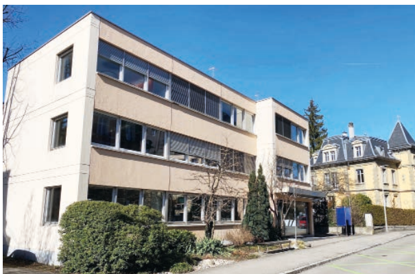
Gebäude vor der Sanierung (Bild: Maya Stalder)
