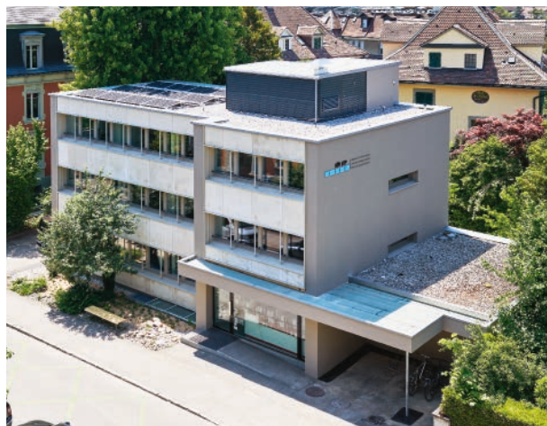
Gebäude nach der Sanierung (Bild: VöV)
