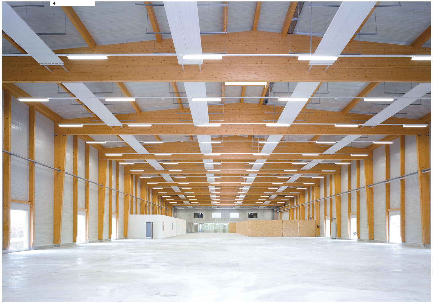
4 grosse Halle mit Deckenstrahlplatten Franz Rindlisbacher
