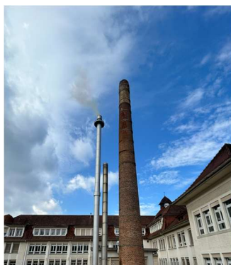
Kamin und Anlage (Quelle: ibe)
